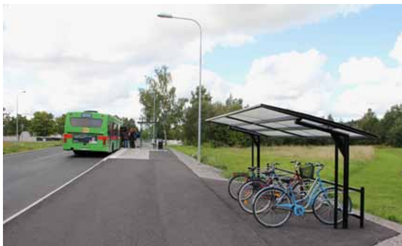
Figur 2.8. Exempel på cykelparkeringar med tak och belysning
