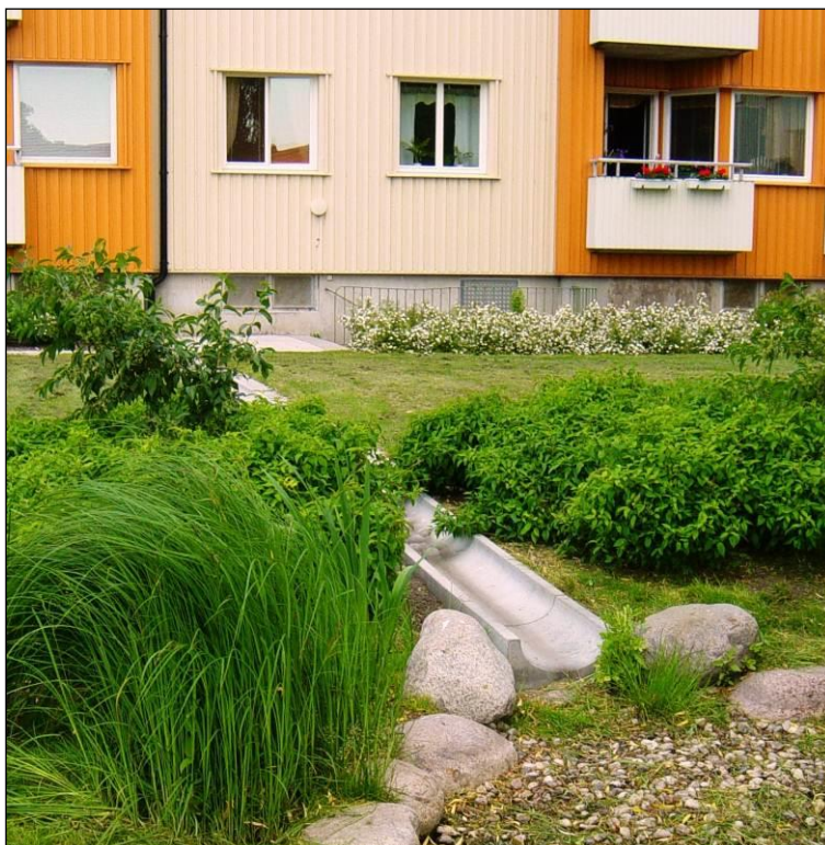
Figur 2 Exempel på ränna för avledning av takvatten
