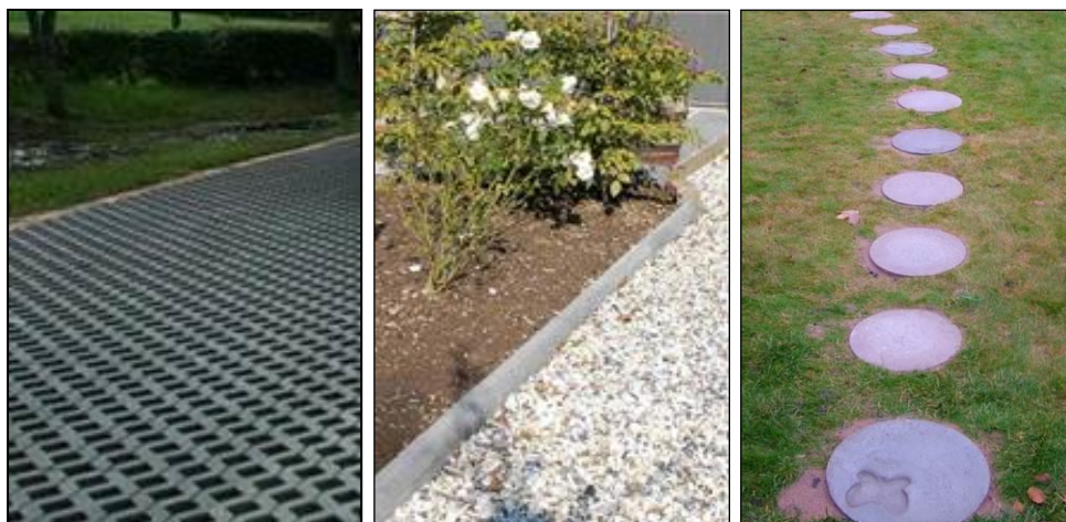
Figur 3 Yta med hålsten av betong, makadambelagd gång, samt gångstig med gräs och ett fåtal gångplattor
