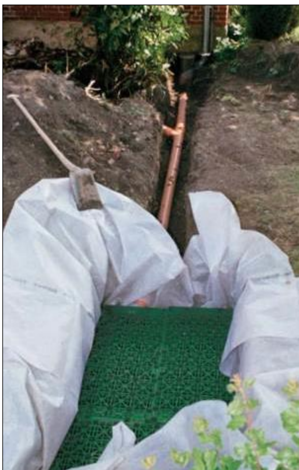
Figur 4 Kassettmagasin för fördröjning av dagvatten
