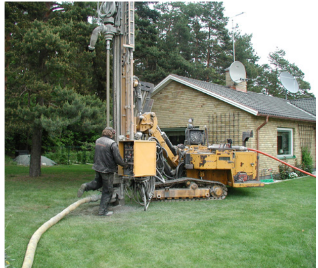
Energibrunnsborrning i Torshälla. Foto: Emanuel Nandorf
