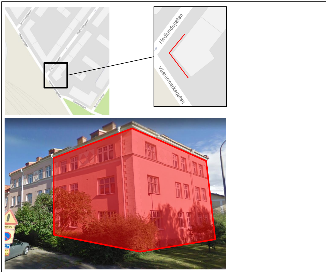
Figur 3. Åtgärdsförtydligande Venus 1. Rött streck visar bullerutsatt fasad och röda markeringar vid fasad redovisar vilka fönster som behöver bytas.
